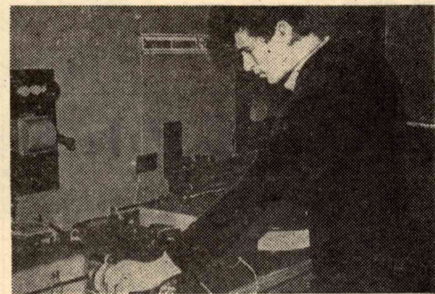
Студент гр. 1028 Г. Татьянченко исследует схему прибора для измерения коэффициента формы кривой.
