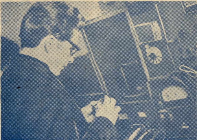
НА СНИМКЕ: В. Дарнин — дипломант кафедры ФТТ за установкой по исследованию диэлектриков на электропроводность при нагревании в вакууме.
