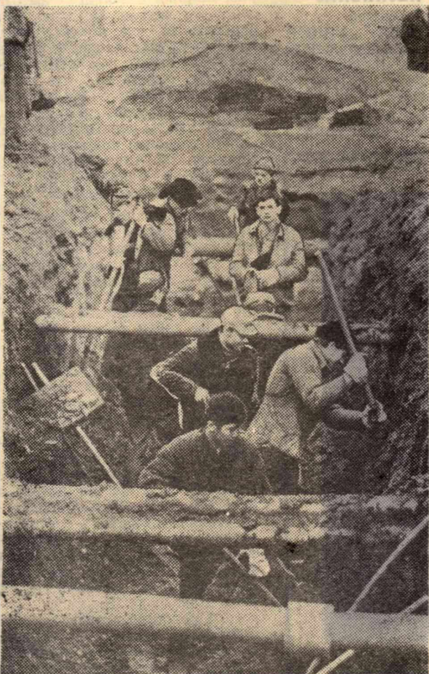
Студенты физико-техники на строительстве теплотрассы. Фото В. Зыбина.
