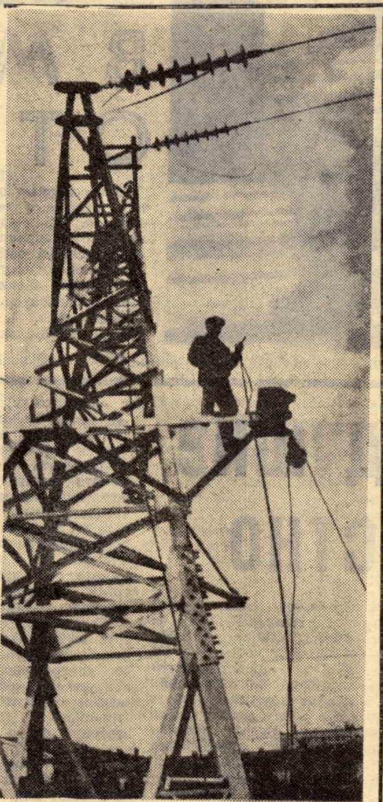
ЛЭП-500 не простаивает линия.
