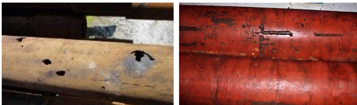
Рисунок 10 - Сквозная коррозия стенки НКТ и погружного электродвигателя
