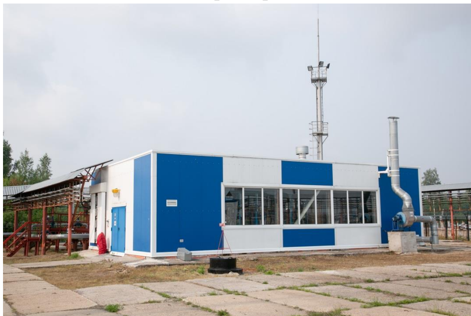
Рисунок 1 – СИКН №1011 ПСП ООО «Томскнефтепереработка»
