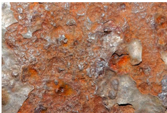
Рисунок № 2 – Сплошная коррозия металла
