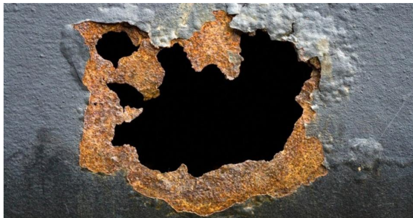
Рисунок № 3 – сквозная коррозия металла
