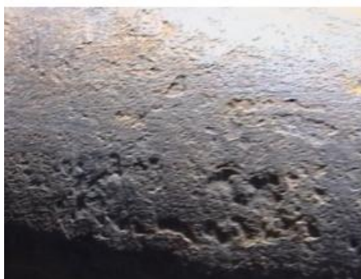
Рисунок № 4 - Язвенная коррозия металла
