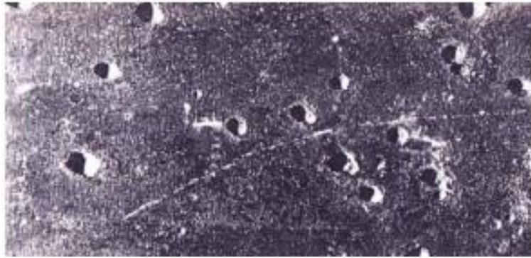
Рисунок № 5- Питтинговая коррозия металла
