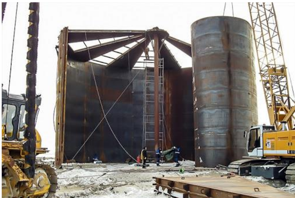
Рисунок 6 - Рулонный способ монтажа РВС
