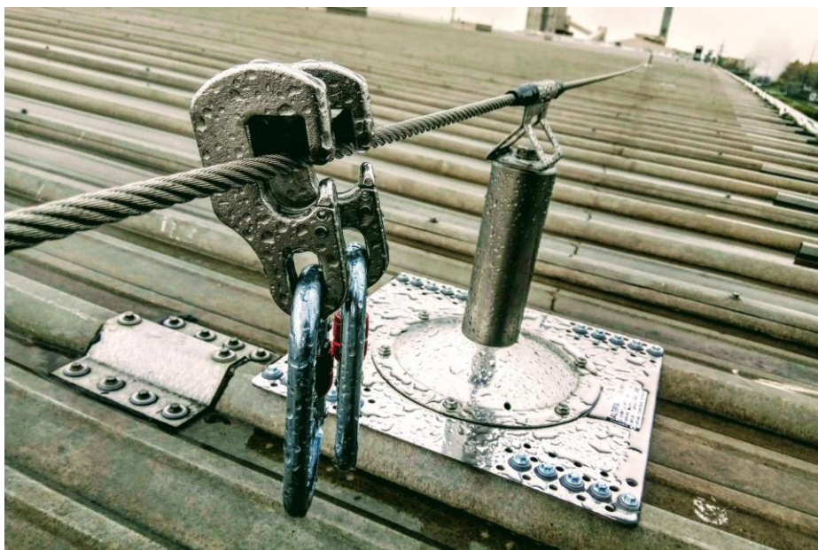
Рис. 6 – Пример исполнения анкерной линии на крыше здания
