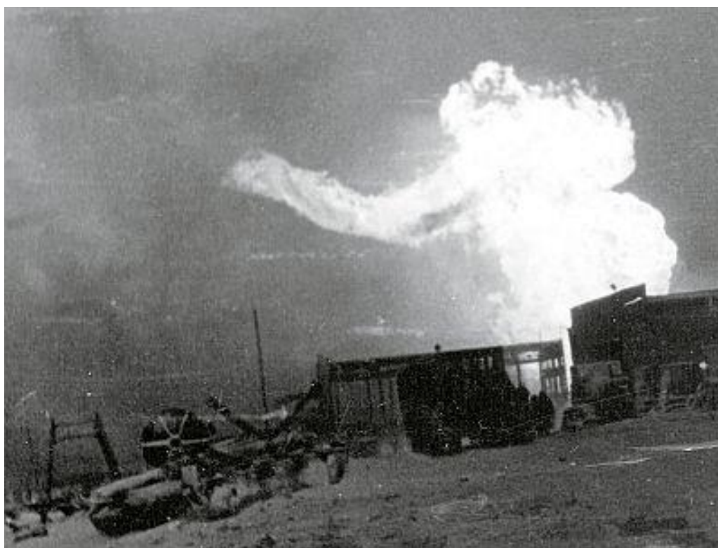
Рисунок 3 – Авария газопровода в 1979 году
