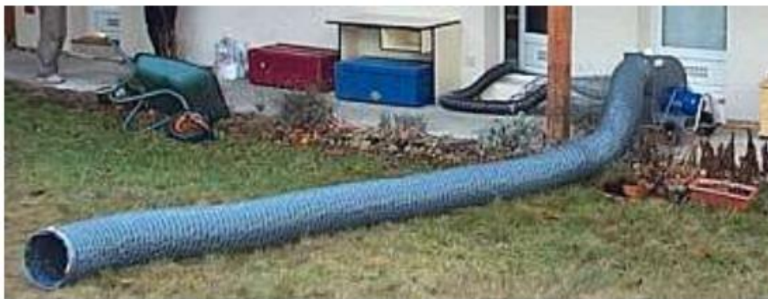
Рисунок 25. Вентиляционный воздуховод вне пространства дома [47].
