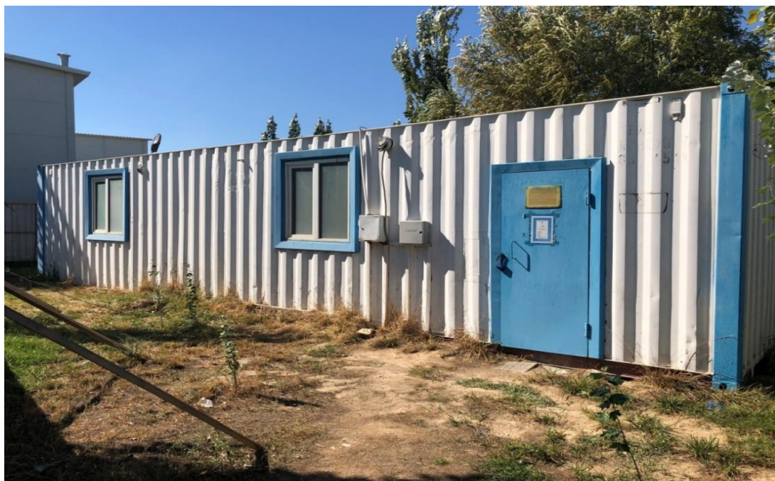
Рисунок 25 – Надземный павильон скважин №№0950, 0951
