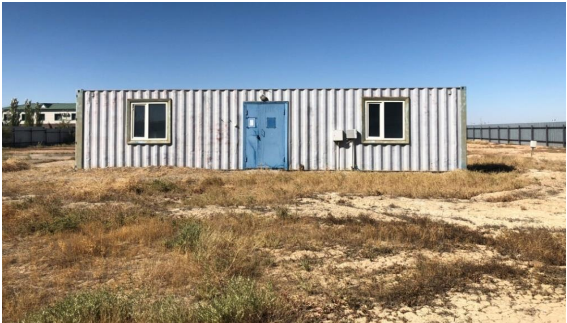
Рисунок 28 – Надземный павильон скважин №№4679, 4680
