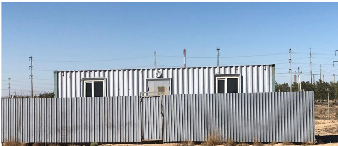
Рисунок 8 – Наземный павильон скважин №№4686, 4687
