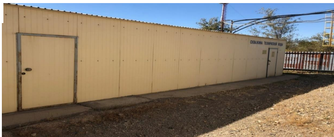
Рисунок 11 – Наземный павильон скважины №№1426, 1427
