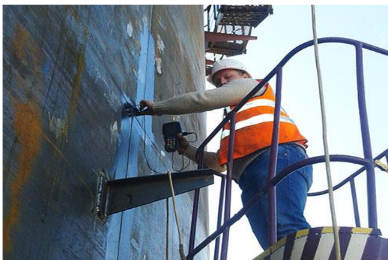
Рисунок 13-Применение дефектоскопа при УЗК РВС
