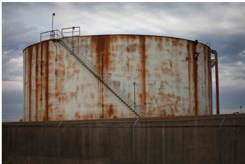
Рисунок 11-Коррозионное повреждение РВС
