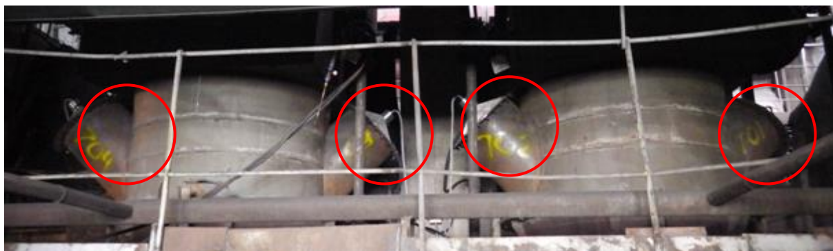
Рис. 14. Фото установленных УЗДИ в трубы Вентури золоулавливающей установки
