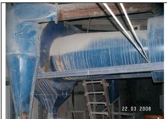
**Рис.5. Фрагмент разработанной установки обеспыливания воздуха системы аспирации узла пересыпки транспортеров известняка**
