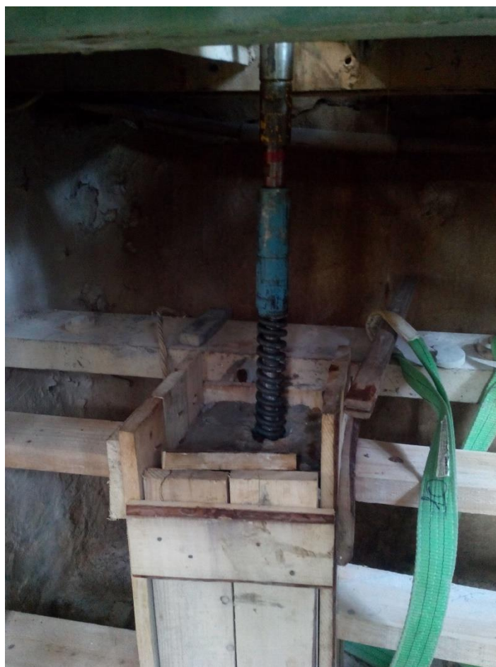
Рисунок 45 – Фото блока при бурении ствола
