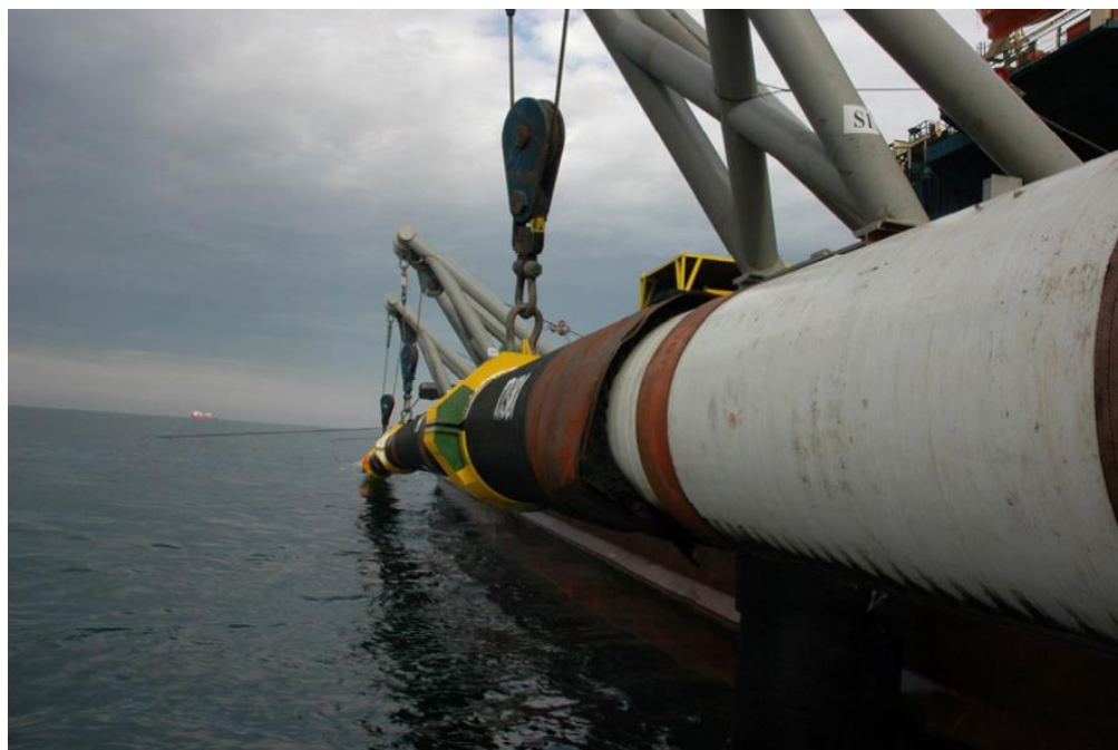
Рисунок 1.23 - Концы секций трубопровода вдоль баржи перед осуществлением надводной сварки
