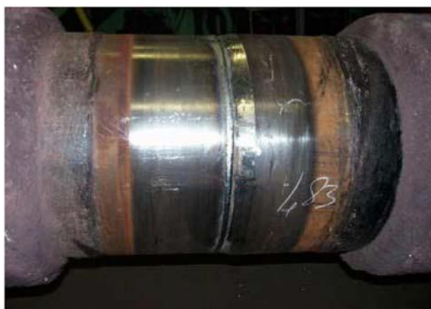
Рисунок 1.13 - Монтажный стык до покрытия [15]
