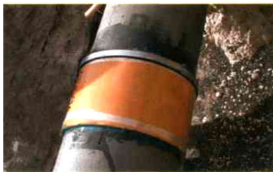
. Отремонтированный участок Рис. 3.7
