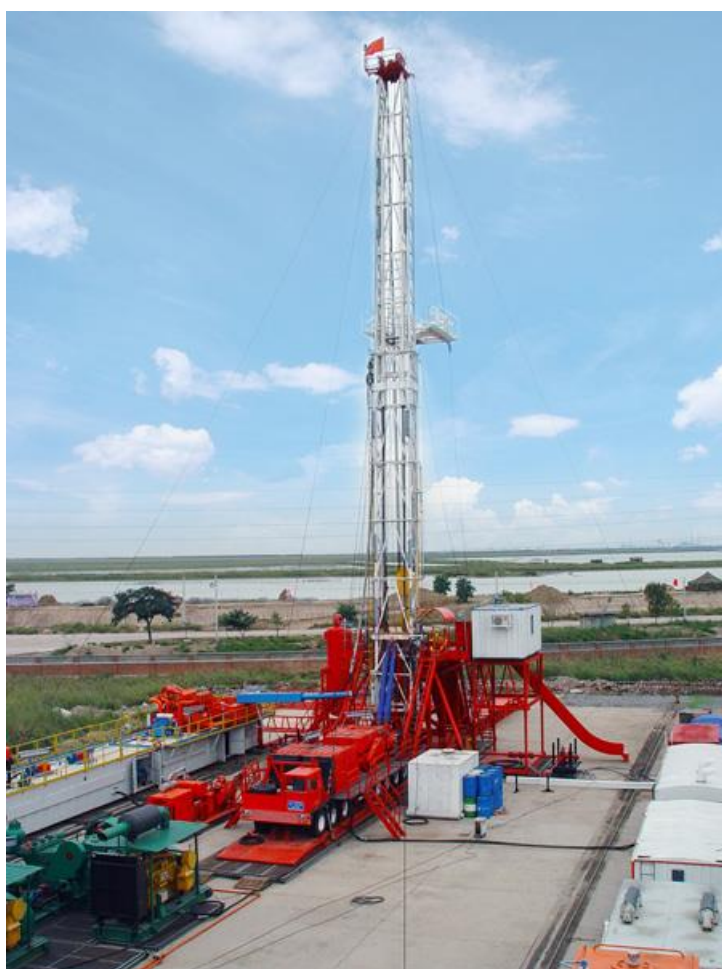
Рисунок 8 – Мобильная самоходная буровая установка ZJ30
