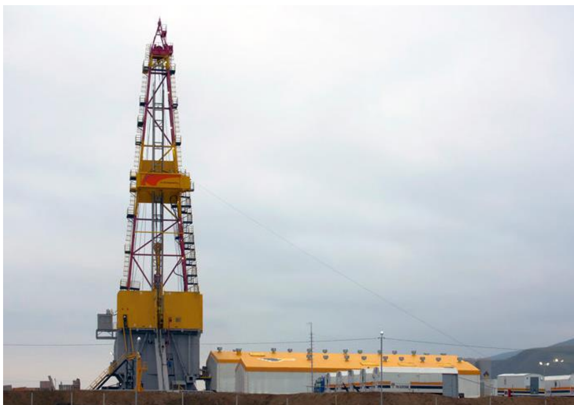
Рисунок 7 – Стационарная буровая установка
