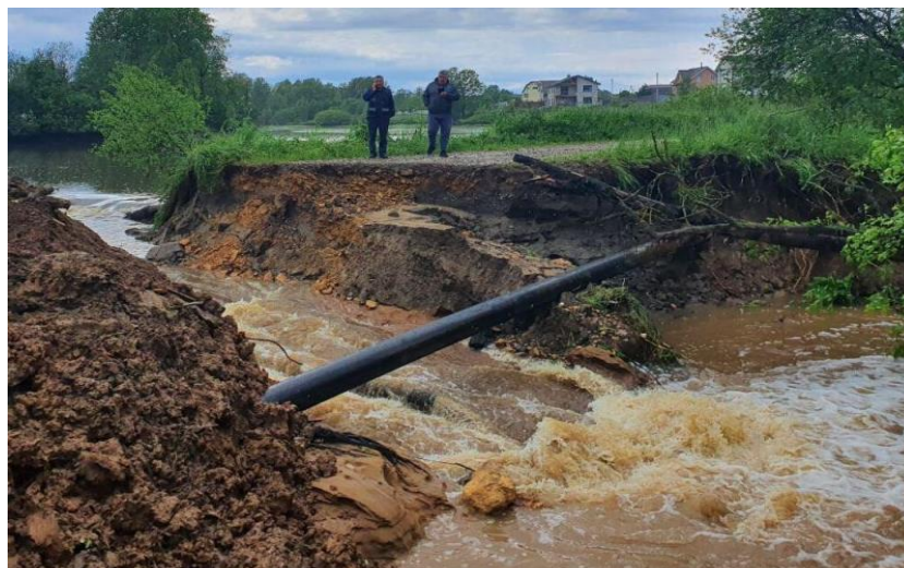
Рисунок 2.2.2 – Участок трубопровода, оголенный селевым потоком
