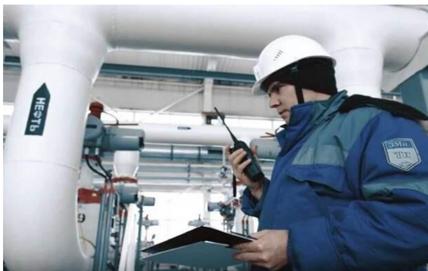
Рисунок 2.3.2 – Выполнение работ по технологическим переключениям на работающем оборудовании МН
