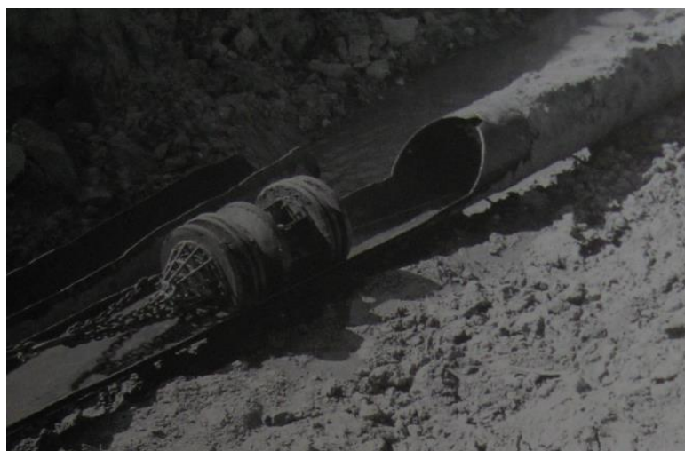
Рис. 2.3 - Вывод очистного поршня из трубопровода
