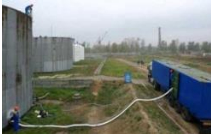
Рисунок 12 – Подача мобильного комплекса к резервуару
