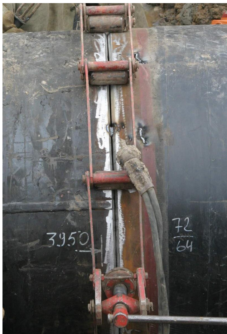
Рисунок 26 – Сборка труб при помощи наружного центратора
