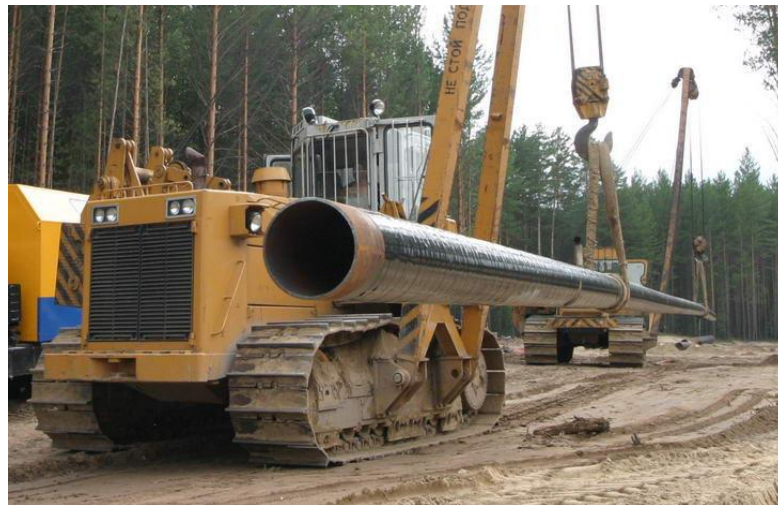
Рисунок 29 – Транспортировка трубных секций трубоукладчиками
