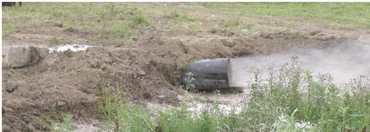
Рисунок 27 – Очистка внутренней полости газопровода с пропуском разделителя
