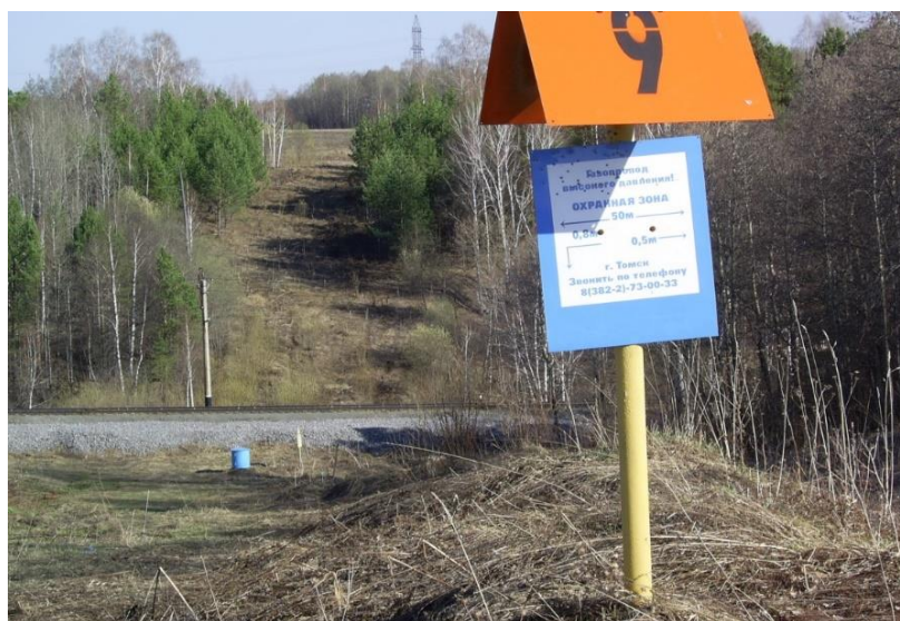
Рисунок 2 – Участок перехода газопровода – отвода к ГРС-1 через железную дорогу и реку Малая Киргизка
