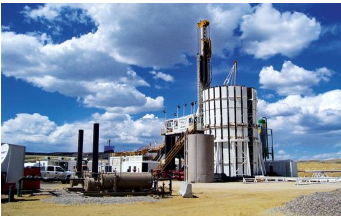
Рисунок 9 - Буровая установка НН-300
