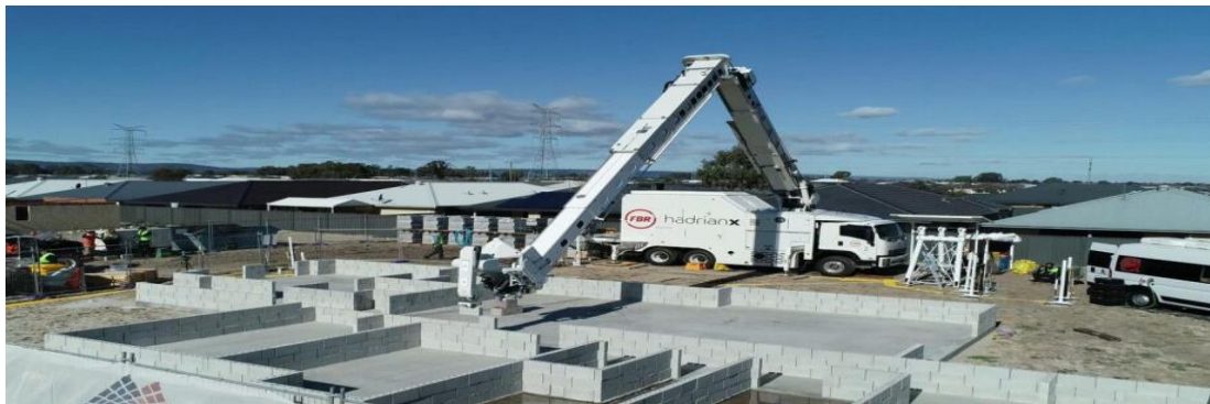
Рисунок 13 - Применение робота-каменщика
