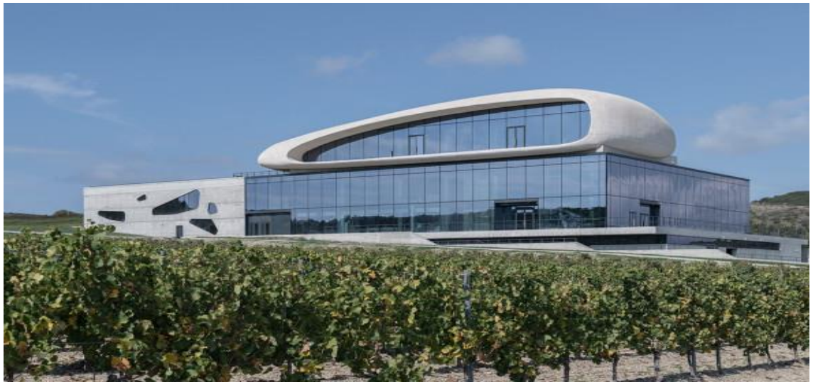
Рисунок 2 - Пример готового здания
