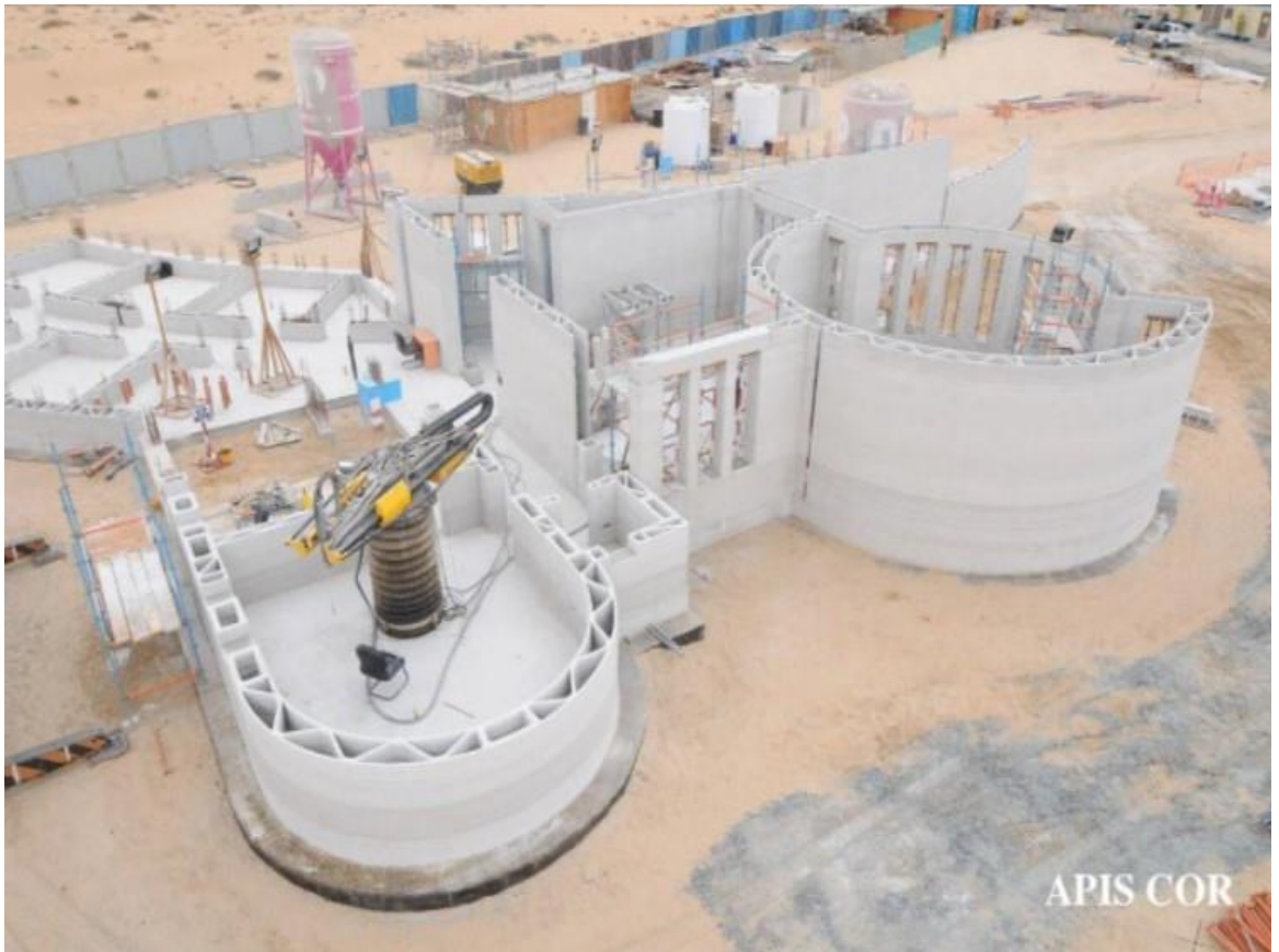
Рисунок 5 - Пример 3 D печати здания
