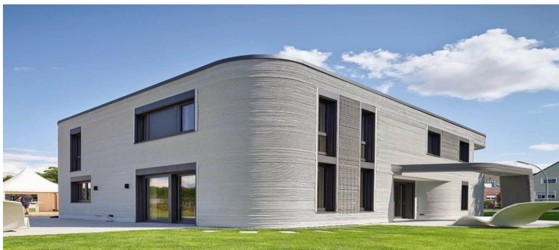
Рисунок 8- Дом в Германии , построенный на 3D принтере
