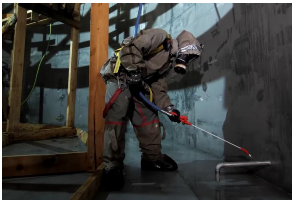
Рисунок 4 – Химический метод очистки резервуаров
