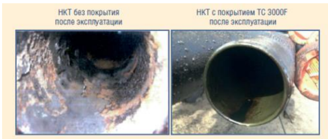
Рисунок 23 - ТС3000 против коррозии
