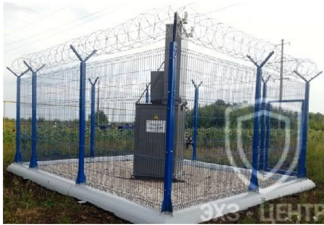
Рисунок 9. Станция катодной защиты
