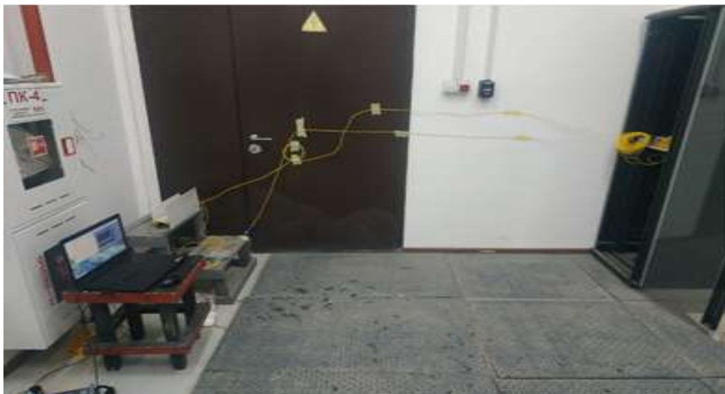
Рисунок 4К – Фото проведения испытаний АПКТК К1 и АПКТК К2
