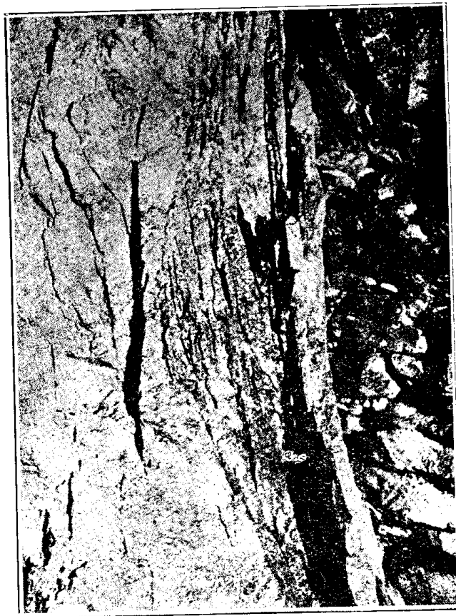
Фот. 4. Вид отскакивающих плиток в момент стреляния в Тауэрнском туннеле.
