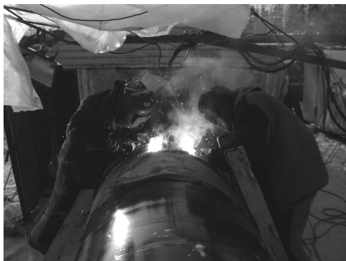
Рис. 2. Техника выполнения швов при сварке магистрального нефтепровода
