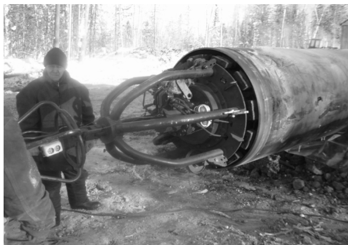
Рис. 1. Установка в трубу внутреннего гидравлического центратора
