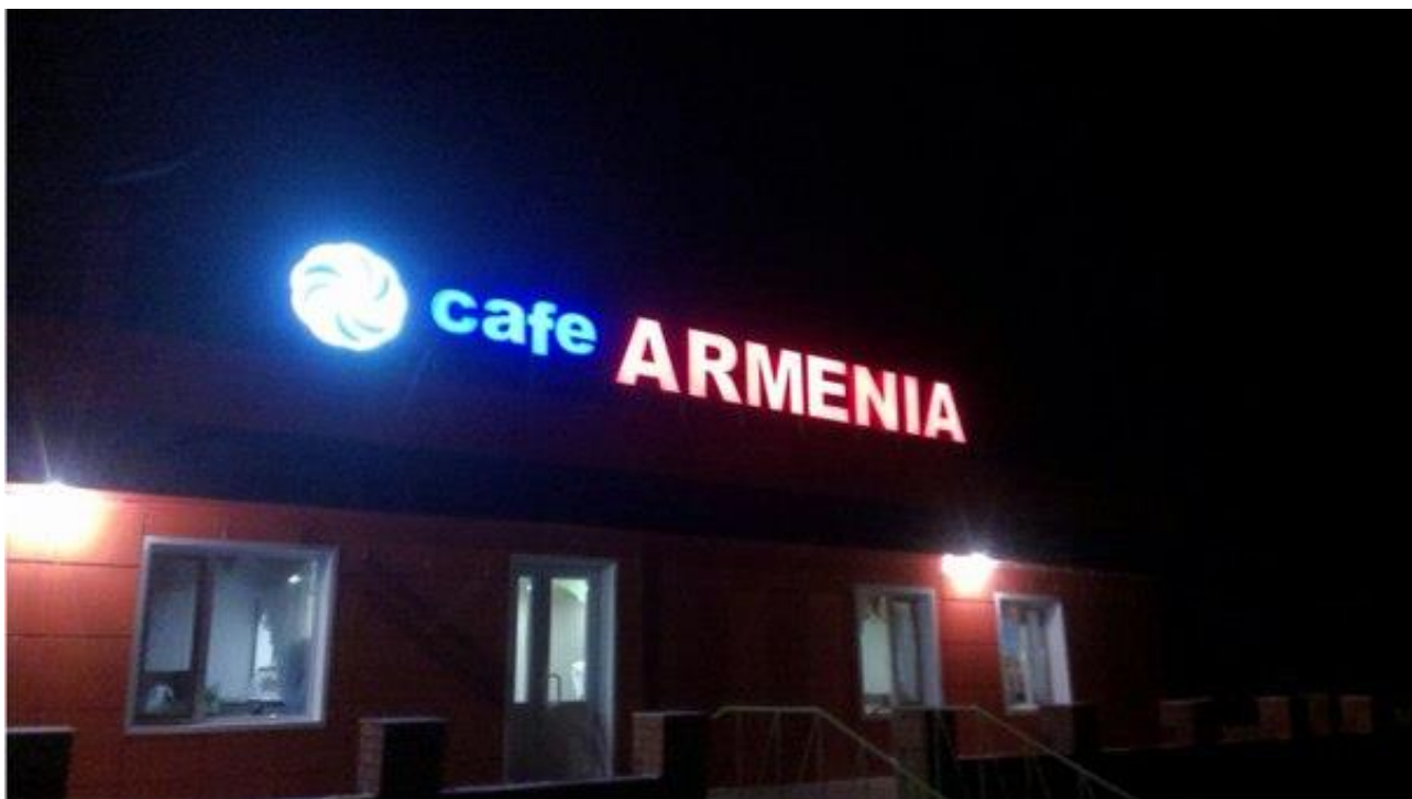
Рисунок 19. Крышная установка кафе «Armenia»
