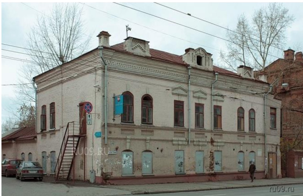
Рисунок 7. Историческое здание проспект Ленина 48
