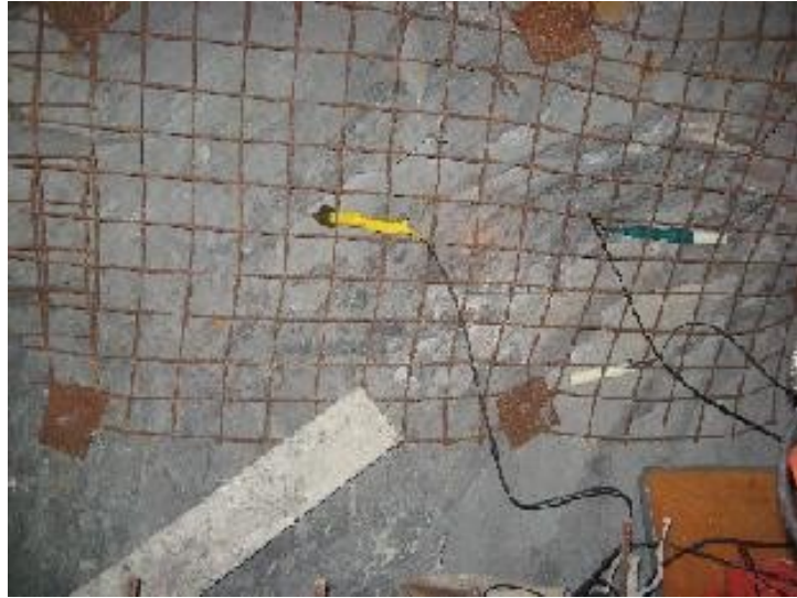
Рисунок 4.13 – Размещение датчиков прибора в шахте
