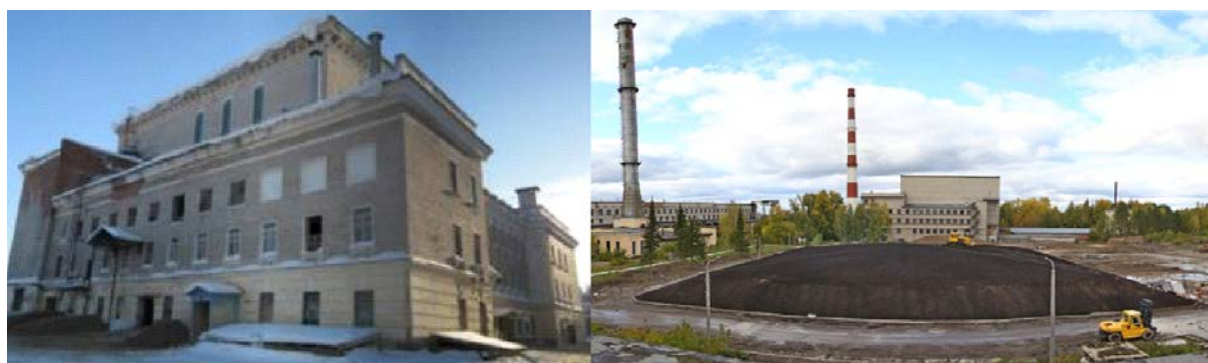
Рис. 5. Внешний вид здания ПУГР ЭИ-2 до начала работ по выводу из эксплуатации в 2011 г. (слева); пункт консервация ПУГР ЭИ-2 по окончании работ в 2015 г. (справа)
