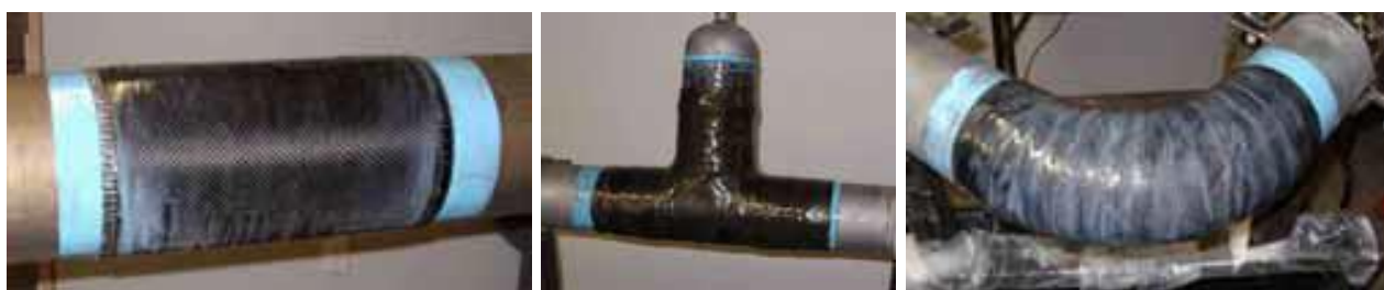
Рисунок 15 – Конструкции отремонтированные системой Black Diamond [16]
