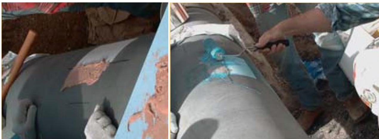
Рисунок 10 – Заделка дефекта мастикой [14]
