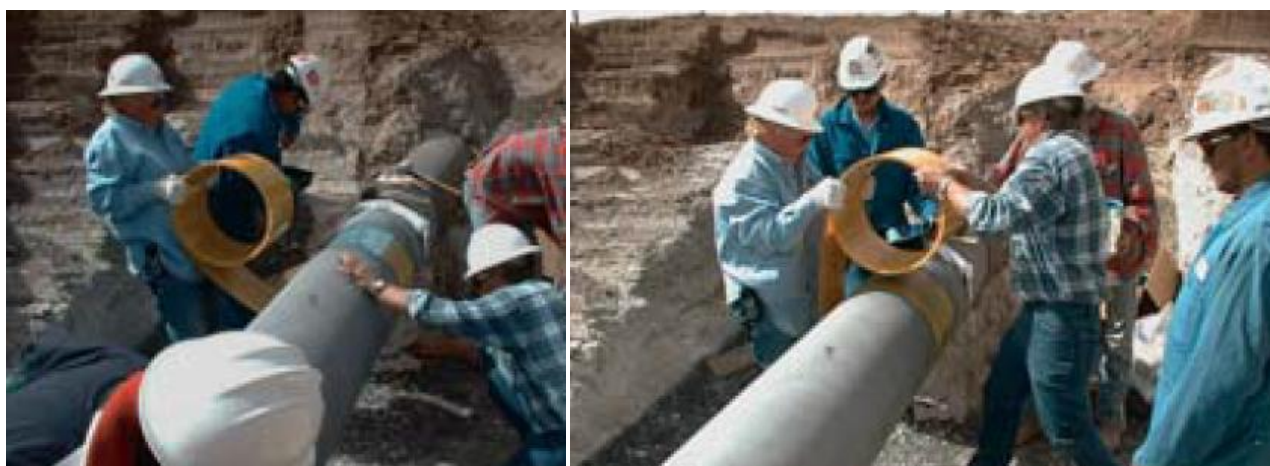
Рисунок 11 – Намотка манжеты на трубопровод [14]
