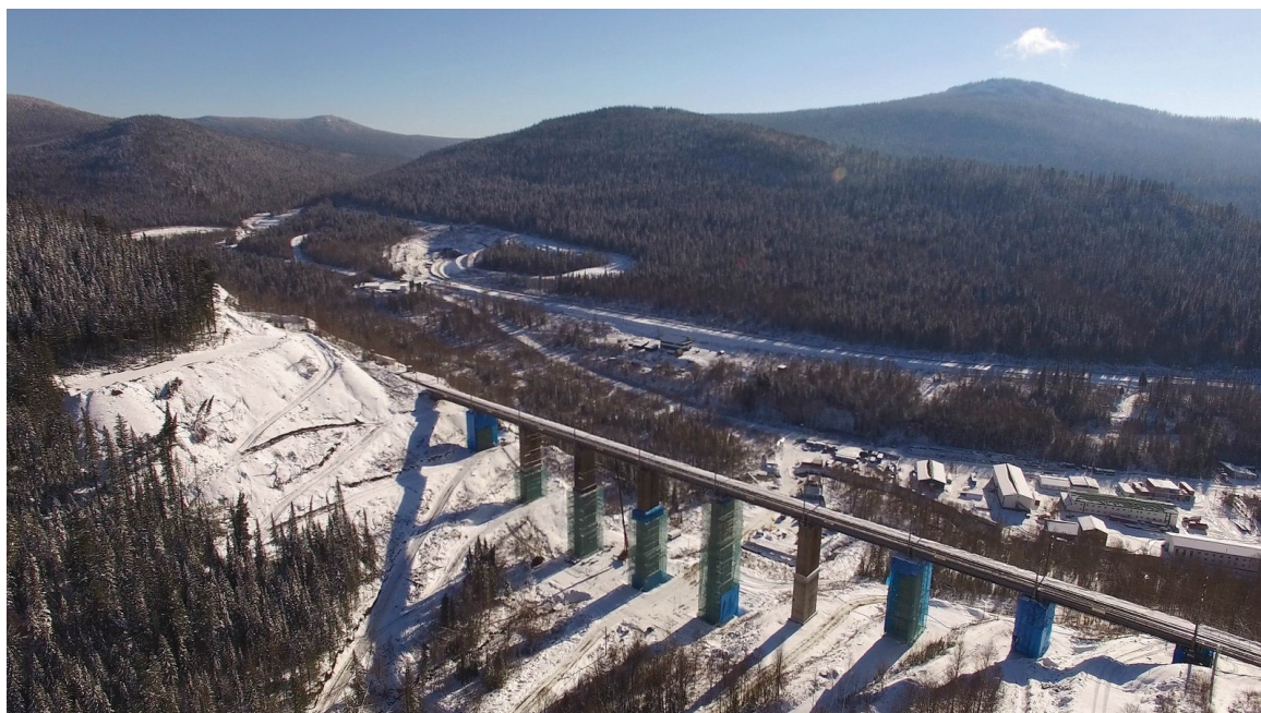
Рис. 1. Фотография участка объекта
