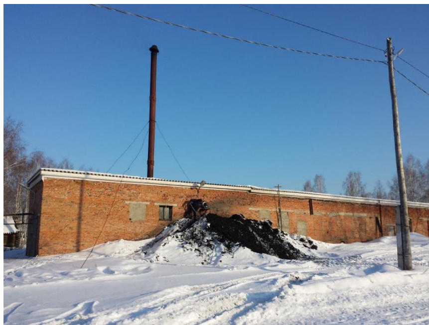
Рисунок 6 – Фотография котельной на угле (село Новониколаевка), (фото Таловской А. В.)
