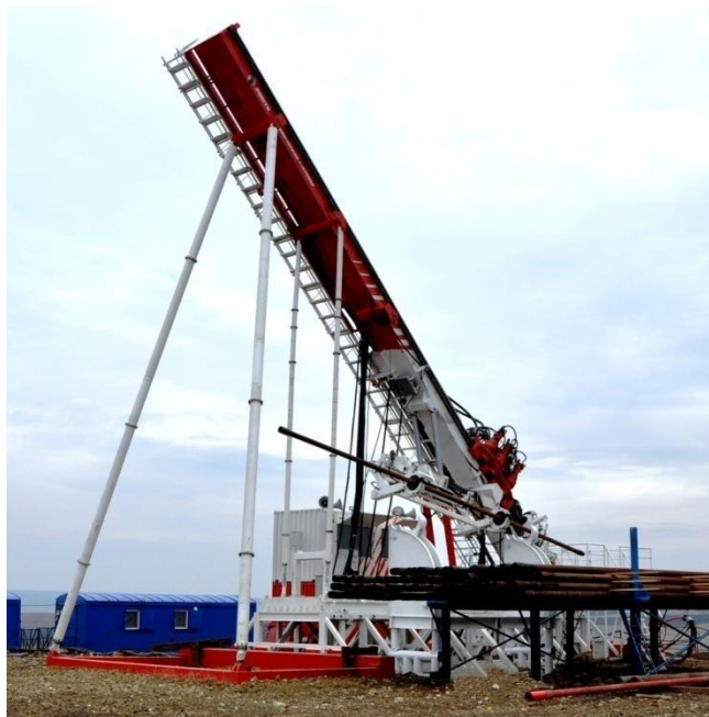
Рисунок 8 –Установка наклонно-направленного бурения
