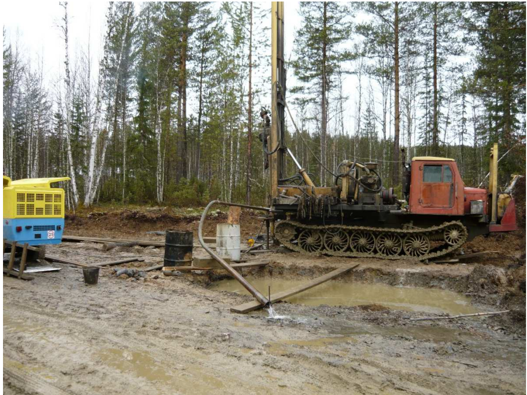
Рисунок 2.4 - Бурение и откачка из скважины № Г-6
