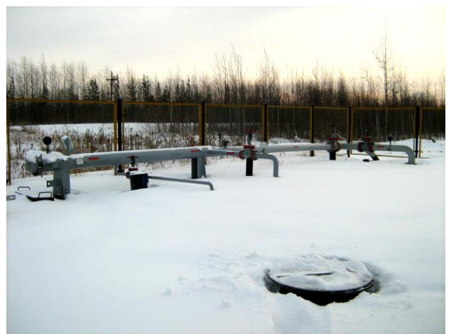
Рис.5 Камера приема СОД[2]
