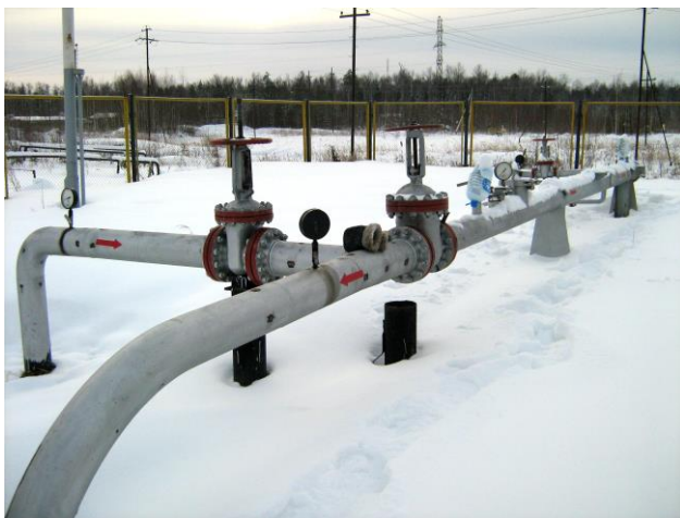
Рис.4 Камера пуска СОД[2]
