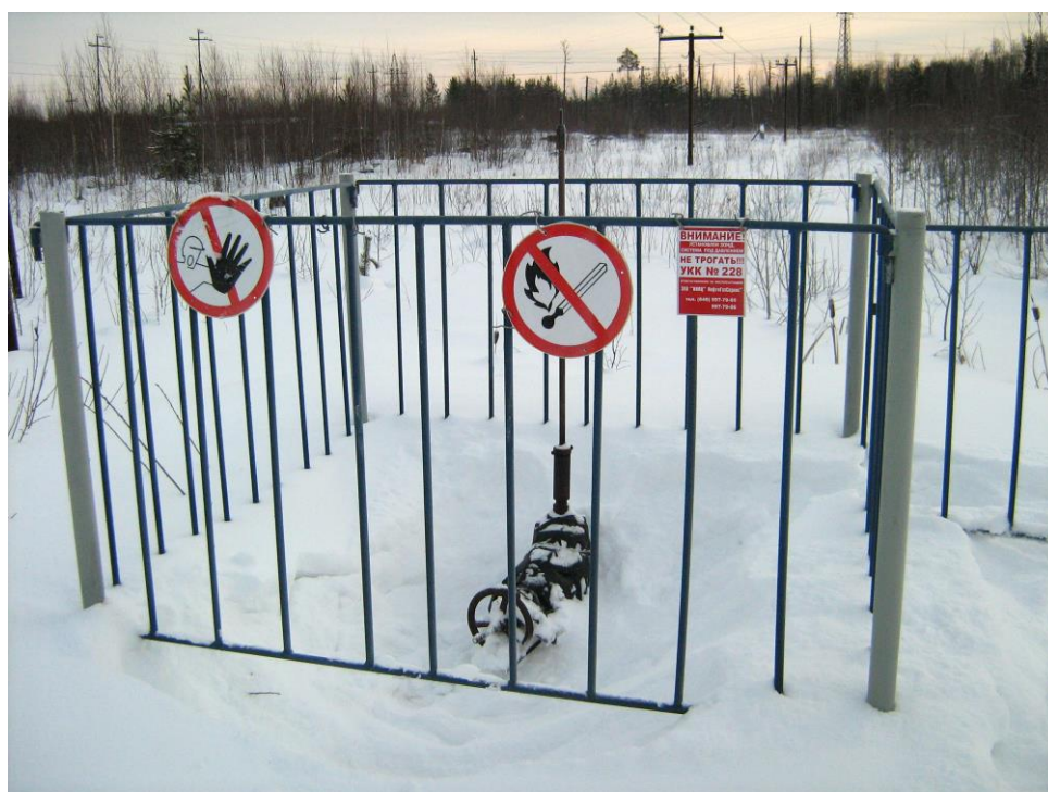
Рис. 12 Узел учета скорости коррозии[22]
