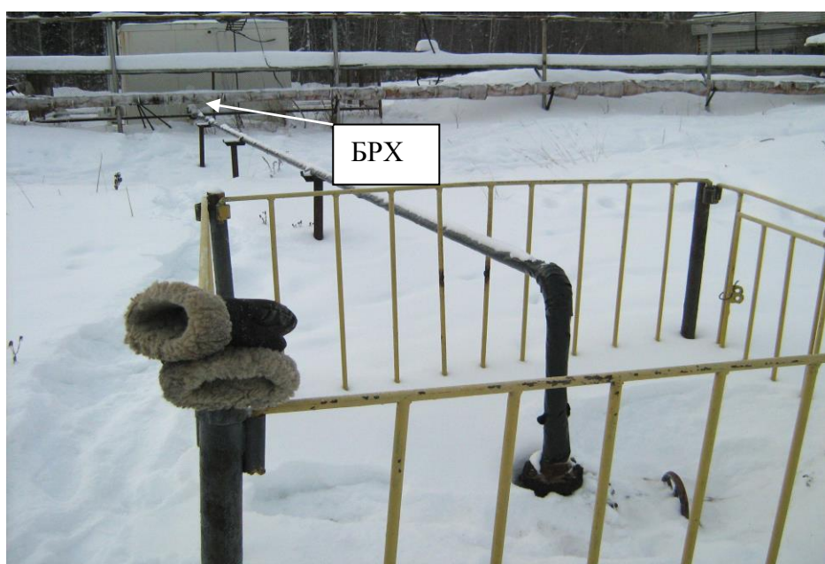
Рис.11 Врезка БРХ в трубопровод[2]
