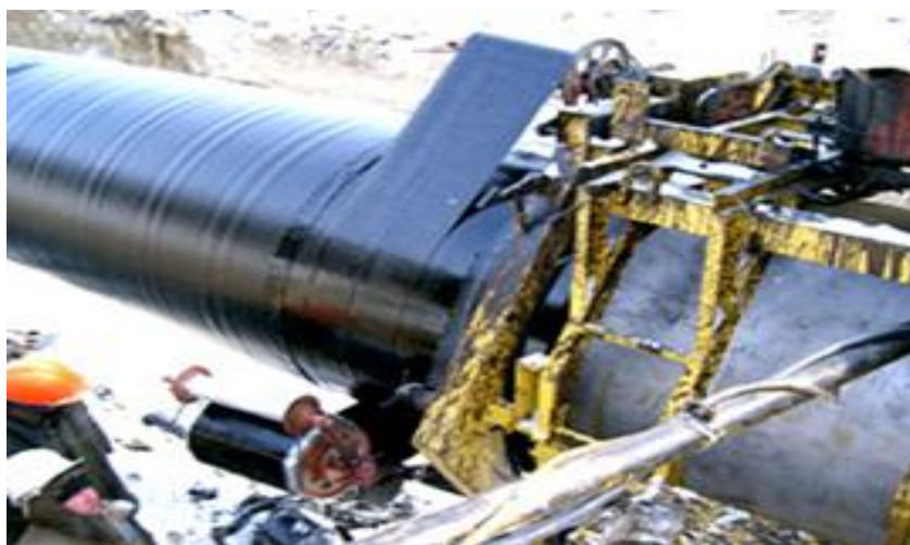
Рисунок 14 – Нанесение изоляционного покрытия в трассовых условиях
