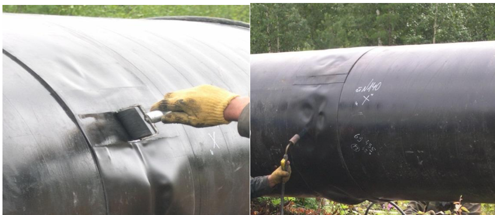
Рисунок 6- Изоляция сварных стыков
