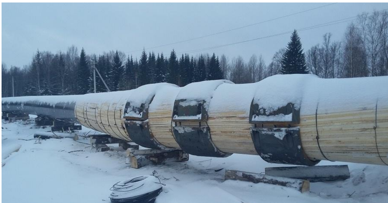
Рисунок 12 - Балластировка трубопровода утяжелителями типа ЧБУ.
