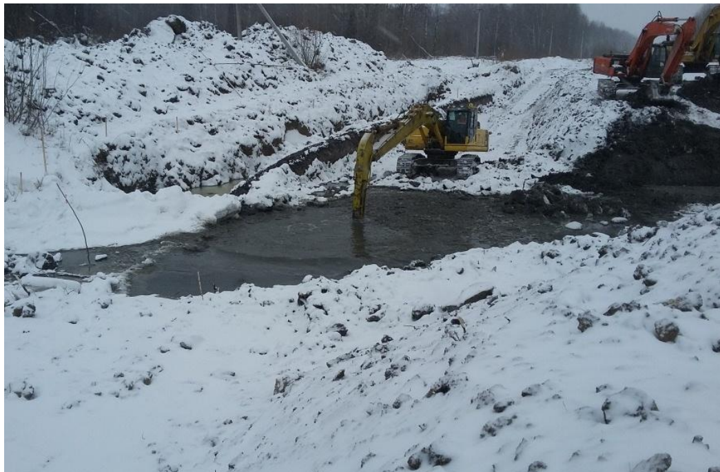
Рисунок 2 - Разработка траншеи в русловой части.
