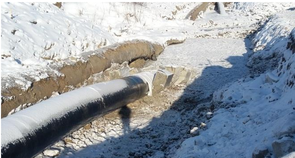
Рисунок 10. - Балластировка трубопровода бетонными утяжелителями типа УБО
