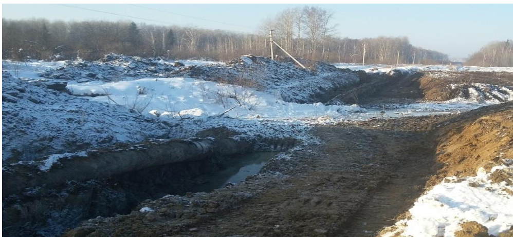
Рисунок 1 - Вскрытие нефтепровода и разработка траншеи
