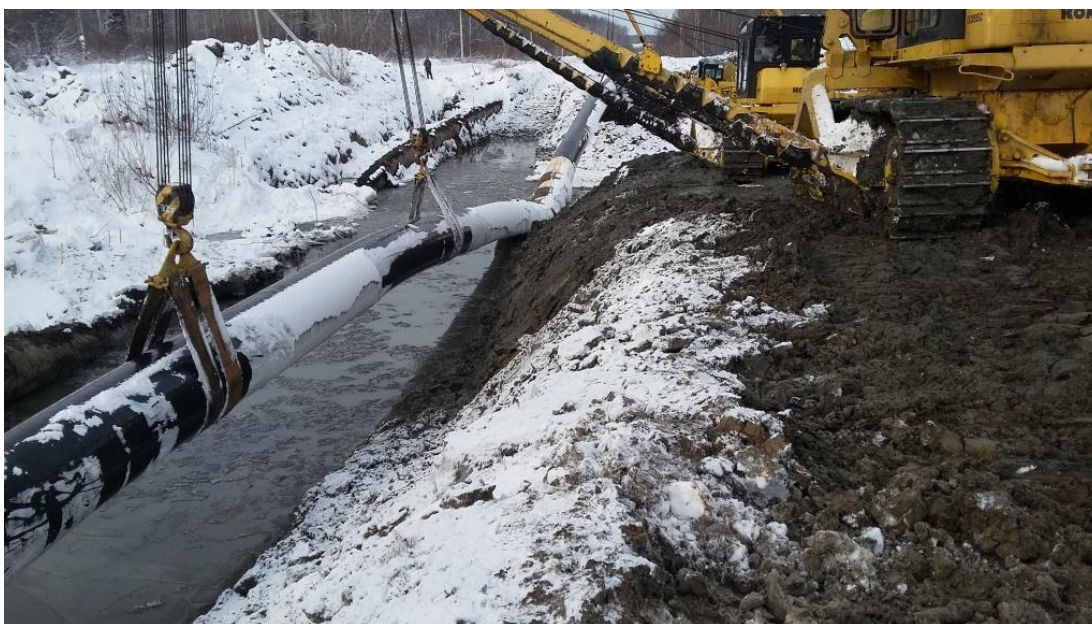
Рисунок 8. – укладочные работы.
