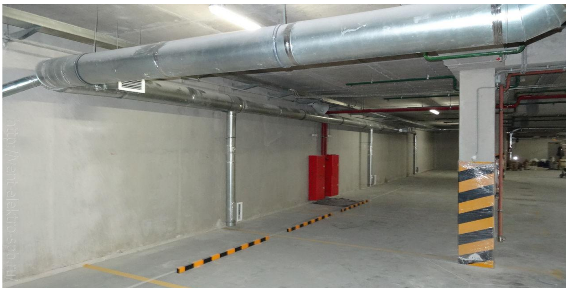
Рисунок 3.3.-Расположение приточных воздуховодов.
