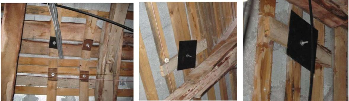
Рисунок 1.7 - Устройство креплений подошвы антенны и растяжек на
