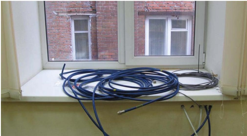
Рисунок 1.9 - Ввод радиотехнических кабелей и кабелей управления под подоконником окна ауд. № 212 4-го учебного корпуса
