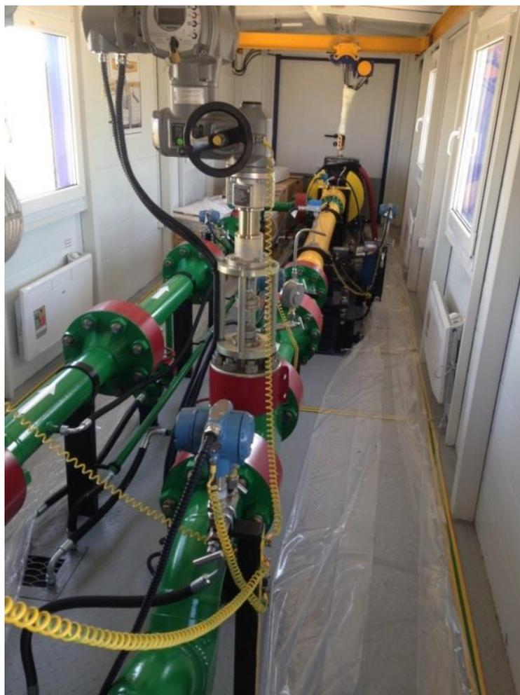
Рисунок 5 – Станция блочная насосная с приводом на основе погружного электродвигателя БНСП 1700-350
