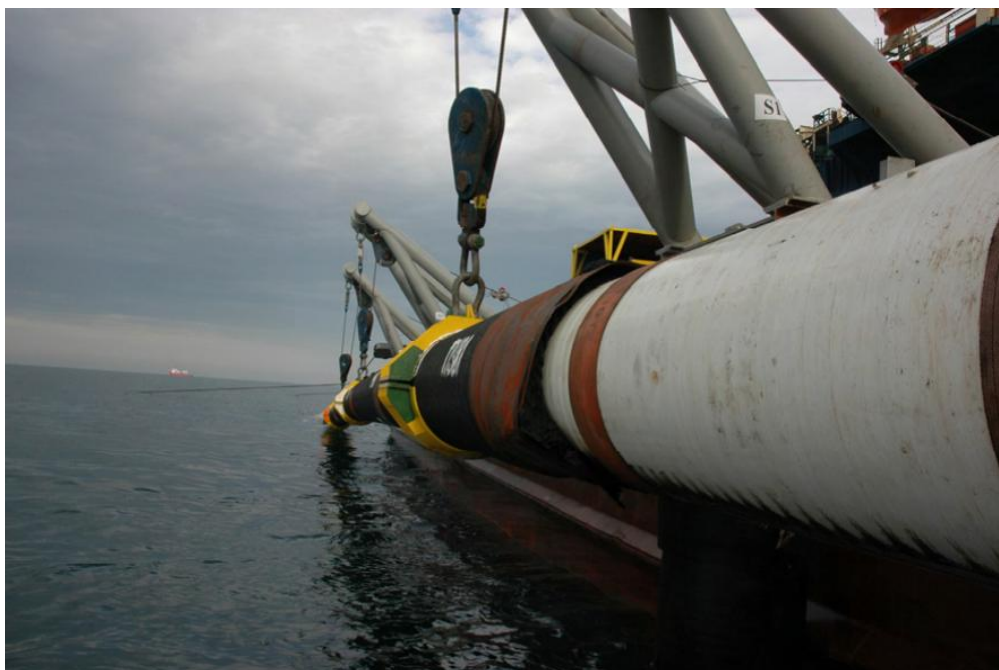
Рисунок 1.3-17 - Концы секций трубопровода вдоль баржи перед осуществлением надводной сварки
