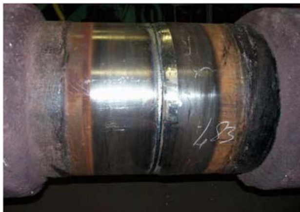
Рисунок 1.45 - Монтажный стык до покрытия. Видно бетонное покрытие
