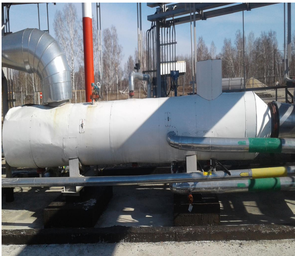
Рисунок 3. Факельный сепаратор
