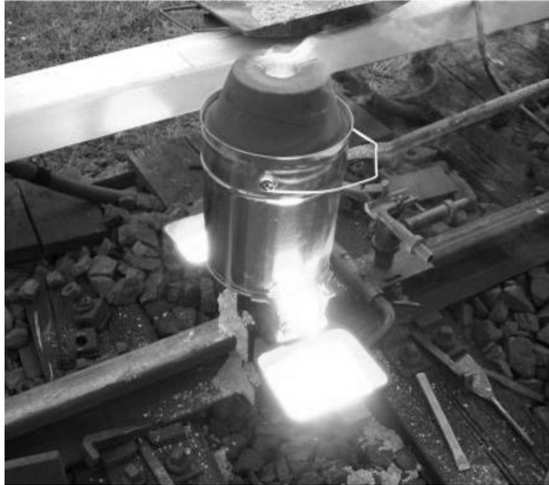
Abbildung 3 – Aluminiumthermitschweißverfahren
