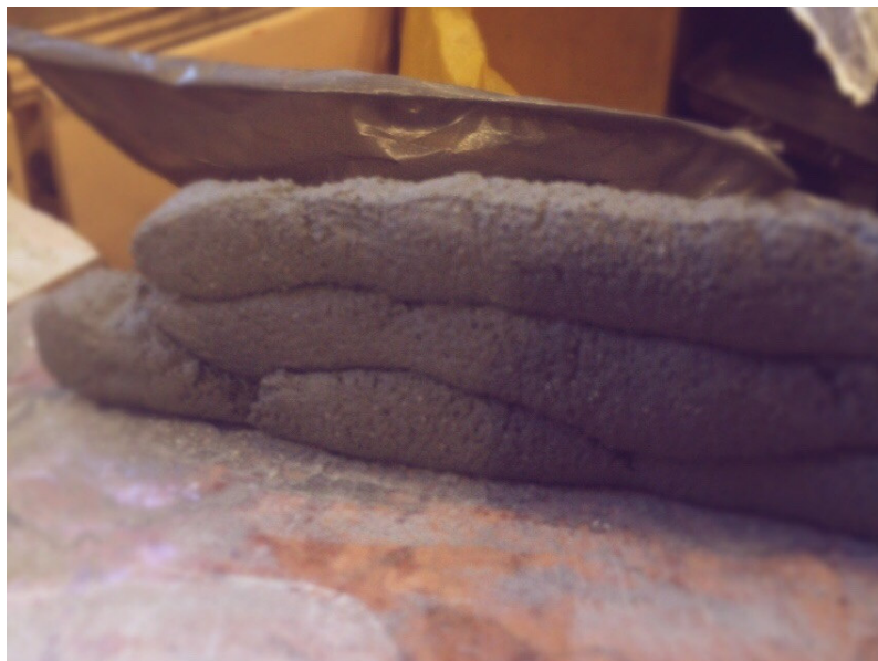
Рис. 2. Послойное нанесение состава №1 цементно-песчаной смеси методом экструзии.
