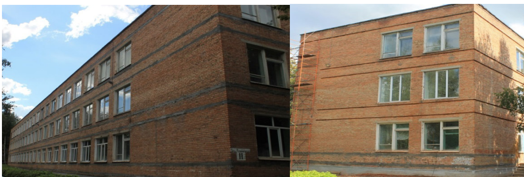
Рис.1. Готовое усиление кирпичных стен
