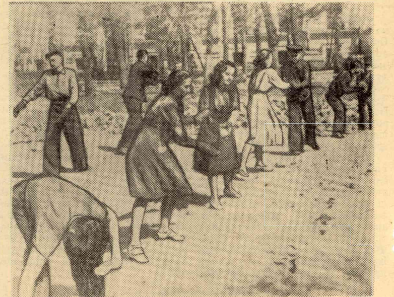
Надо скорее разобрать мостовую, завтра здесь будет работать экскаватор.
